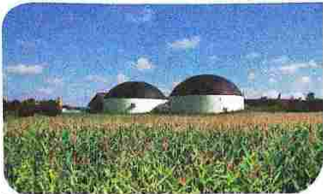
➊ Fasilitas pembuat biogas.
