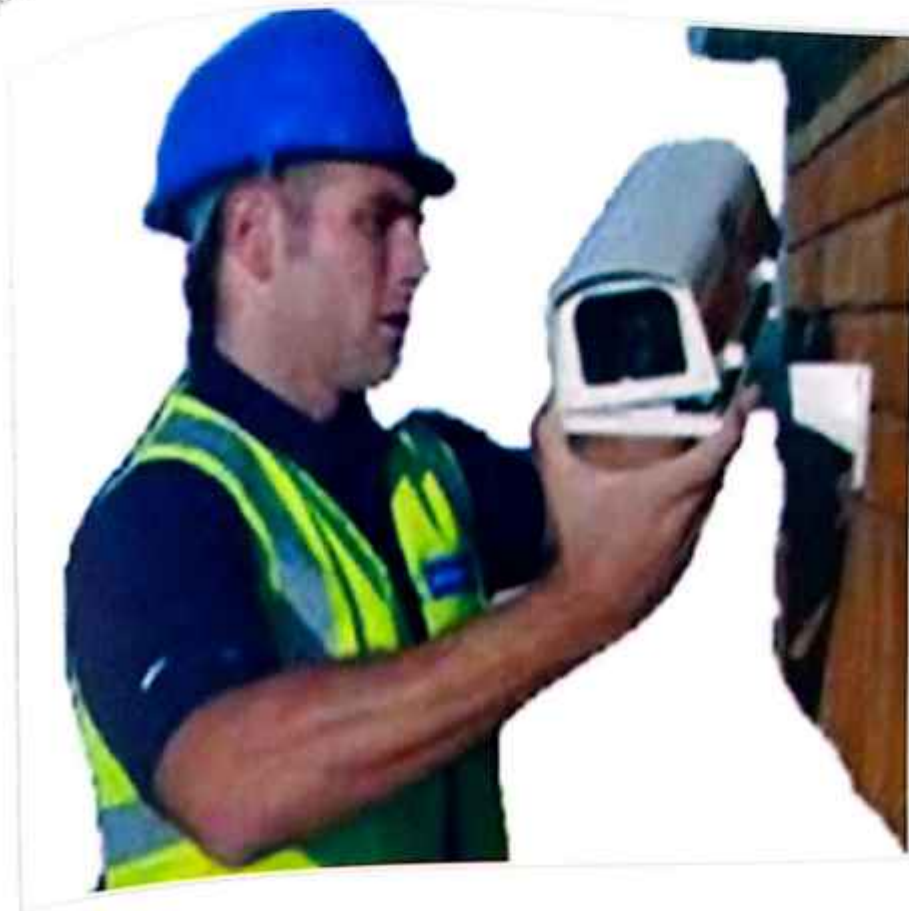
Gambar 6.1 Cara Pemasangan kamera CCTV
